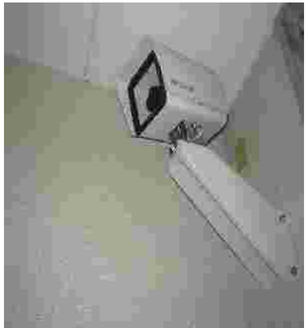
16号棟エレベーター脇に仮設置のカメラ
